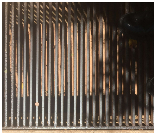
Figura 7 - Esempio di griglia di captazione con r=0.60 formata da barre di acciaio pieno a sezione rettangolare
