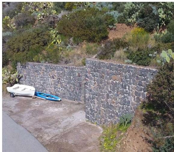
Figura 8 - Rivestimento murario del serbatoio alto dell'acquedotto di Pecorini, a quota 153m s.l.m. (Foto da drone, marzo 2021)
